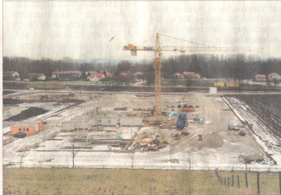
Die Firma Schuster baut im Gewerbegebiet „Hackerwiese“ derzeit ein Autohaus. Weitere Betriebe sollen folgen. (Foto: Jörg Schlegel)
